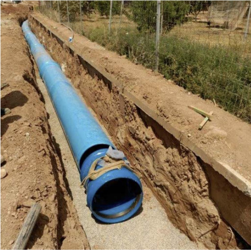
Ilustración 30.- Zanja con tubería PVC-O 500 y pieza especial acoplada.
